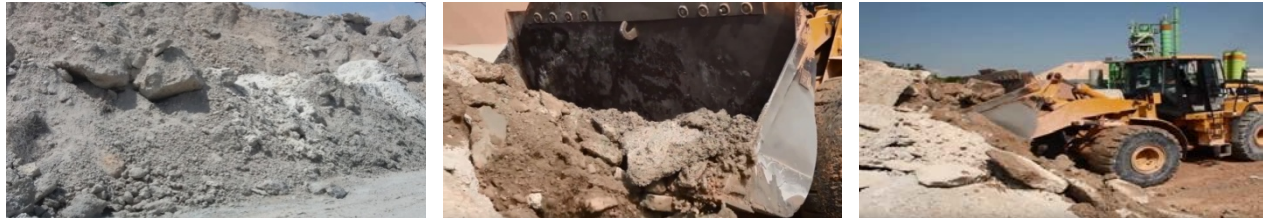
شكل (4) التخلص من مخلفات الخرسانة الطازجة وذلك بوضعها على الأرض حتى تصلدها ومن ثم نقلها إلى المقالب العمومية
